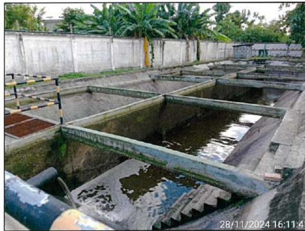
รูปที่ 3.3-2 บ่อพักน้ำที่รองรับน้ำทิ้งที่ผ่านการบำบัด
