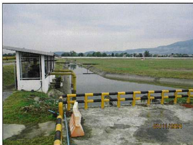
รูปที่ 3.3-16 รางระบายน้ำฝน และสถานีสูบน้ำในพื้นที่ ทชม.
