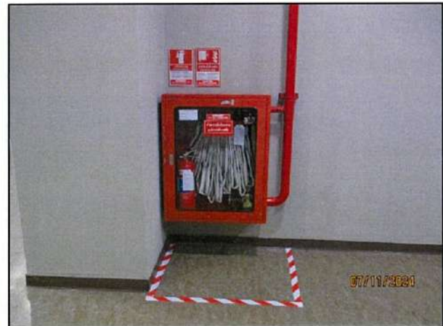
รูปที่ 3.3-26 การจัดเตรียมอุปกรณ์ป้องกันและระงับเหตุอัคคีภัย รวมทั้งการจัดเตรียมจุดรวมพลไว้บริเวณพื้นที่ต่างๆ ภายในพื้นที่ท่าอากาศยาน
